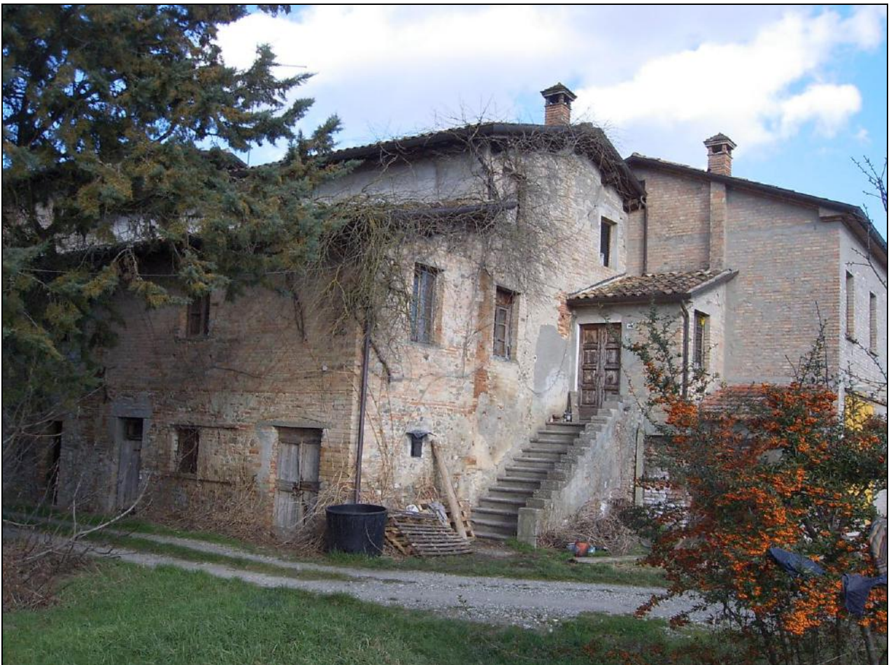
FOTO N°4: PORZIONE PROSPETTO SUD-OVEST
