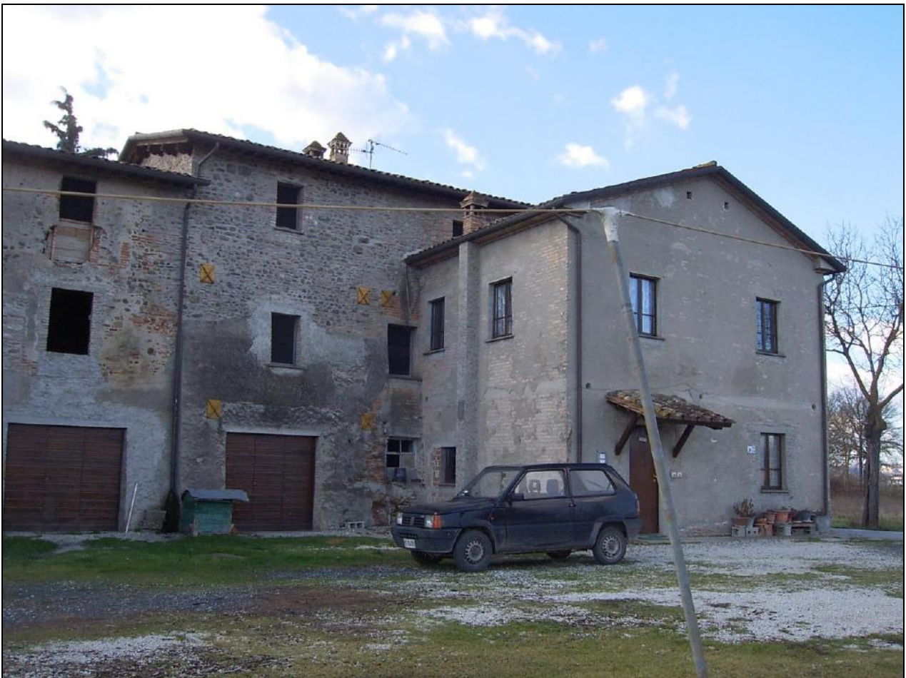
FOTO N°8: PORZIONE PROSPETTO NORD-EST
