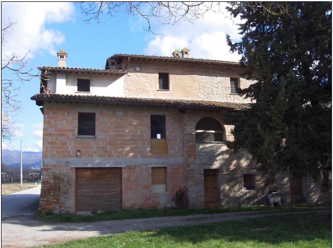
FOTO N°2 : PORZIONE PROSPETTO SUD-OVEST
