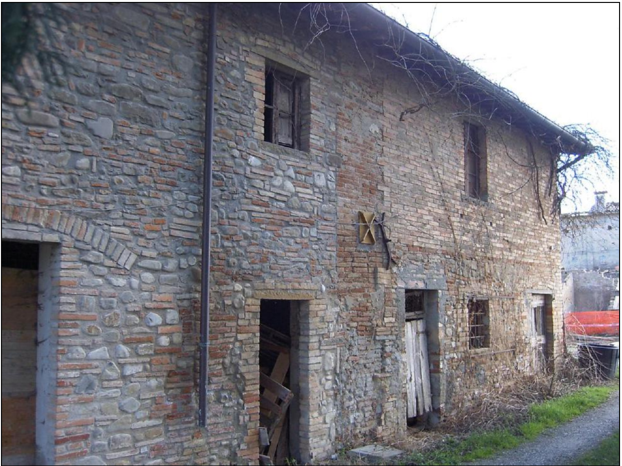
FOTO N°3: PORZIONE PROSPETTO SUD-OVEST
