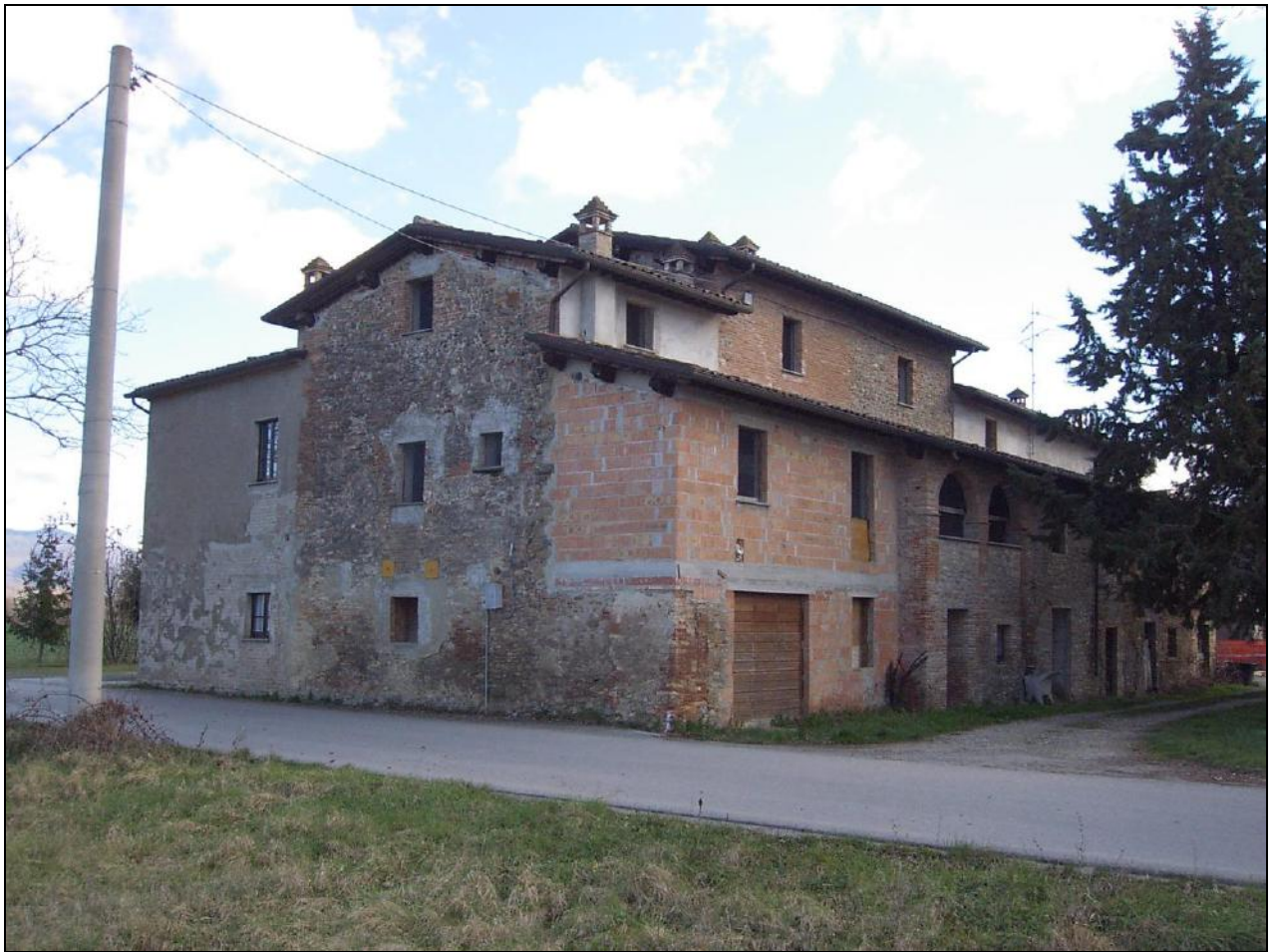
FOTO N°1 : PROSPETTI NORD-OVEST E SUD-OVEST
