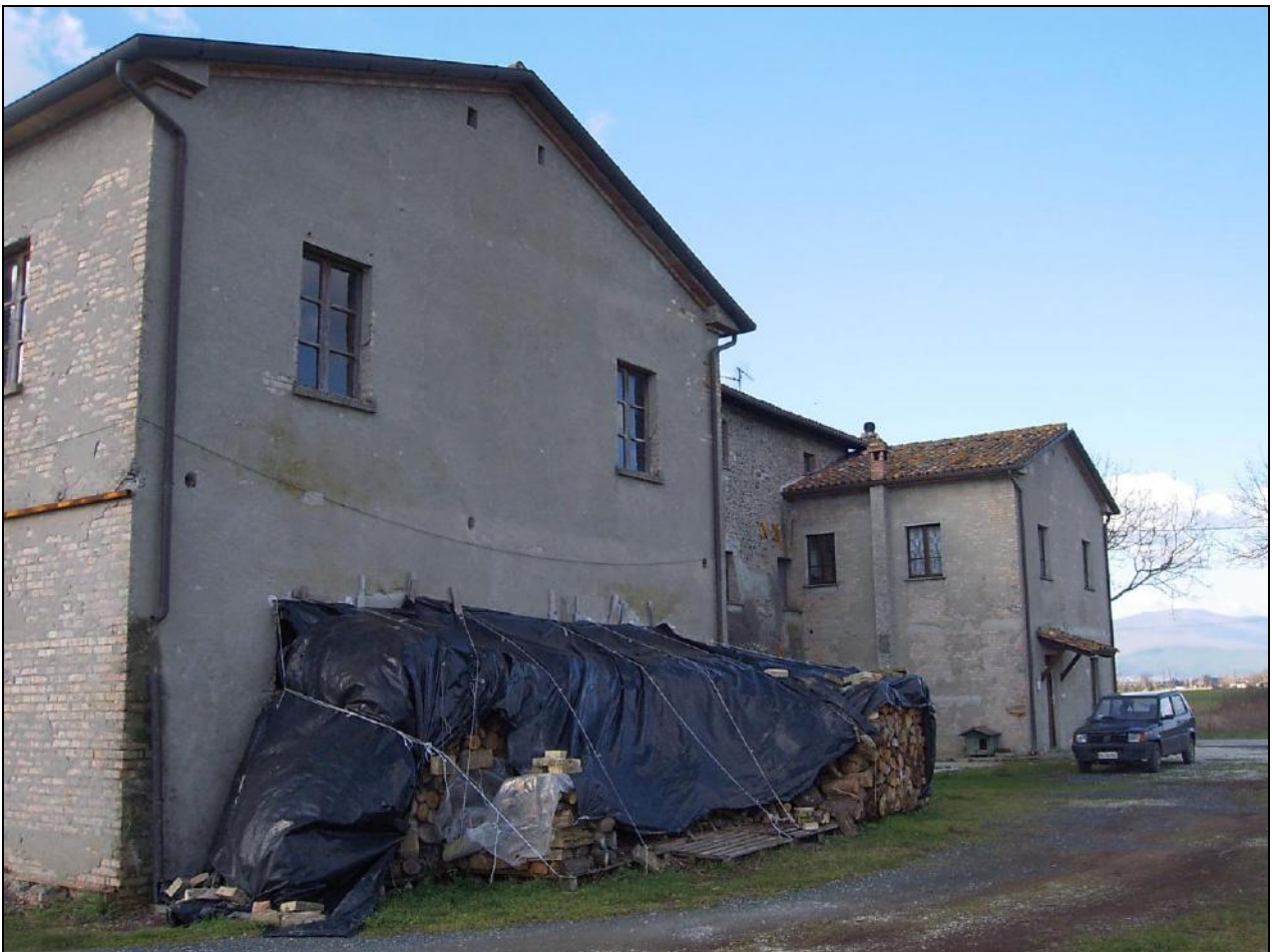
FOTO N°6: PORZIONE PROSPETTO NORD-EST
