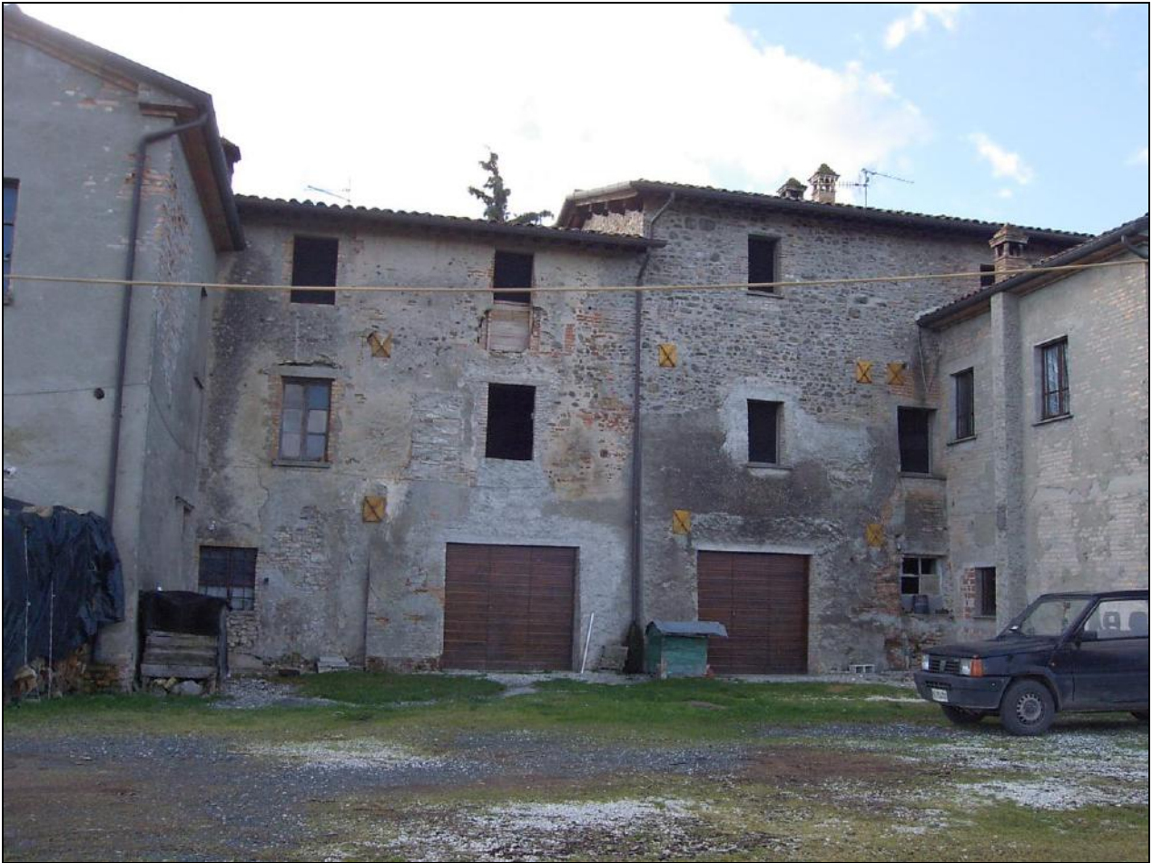
FOTO N°7: PORZIONE PROSPETTO NORD-EST
