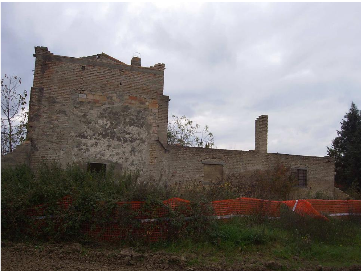
FOTO N°14: PORZIONE PROSPETTO NORD-EST
