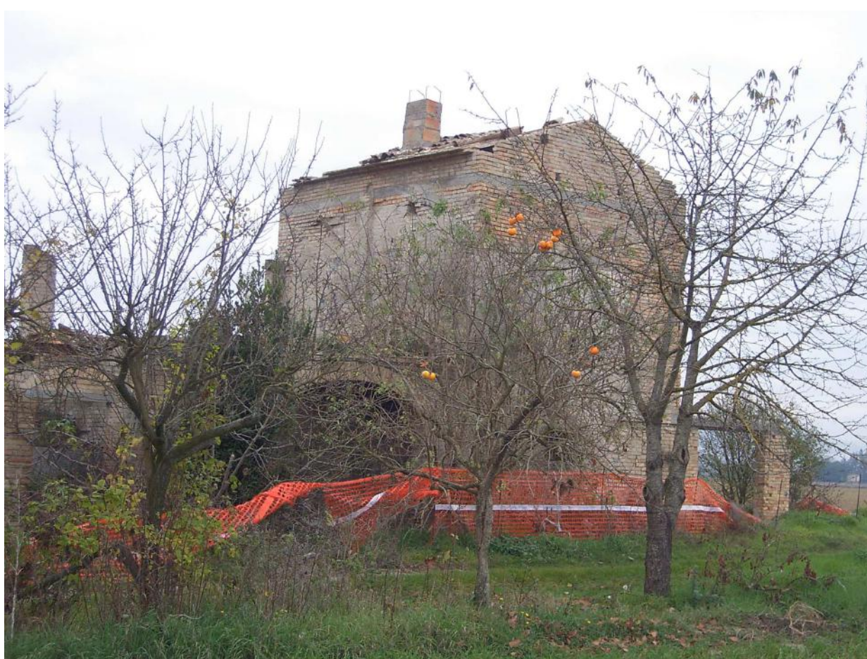
FOTO N°10 : PORZIONE PROSPETTO SUD-OVEST
