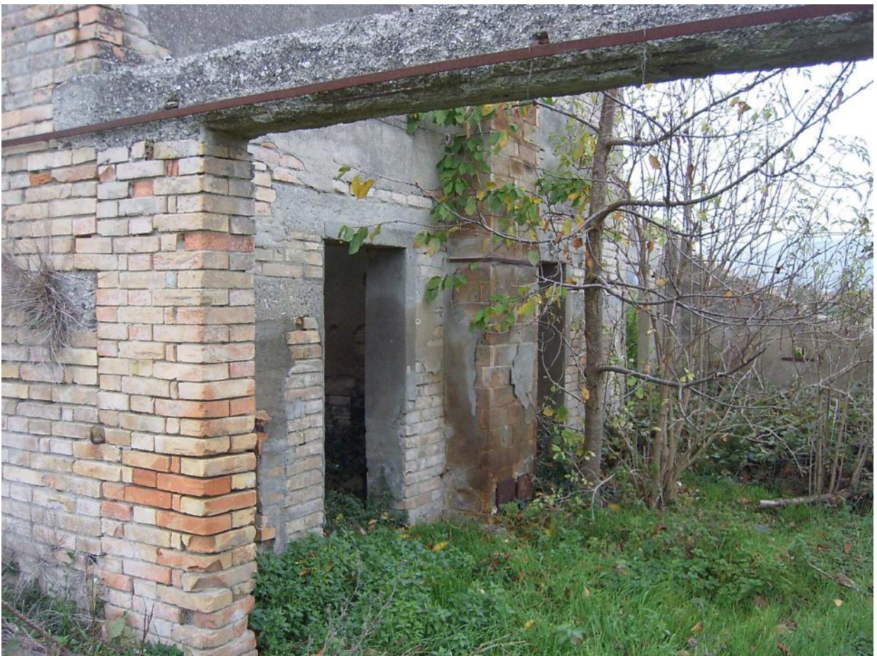
FOTO N°12 : VISTA DALL'INTERNO PROSPETTO SUD-EST
