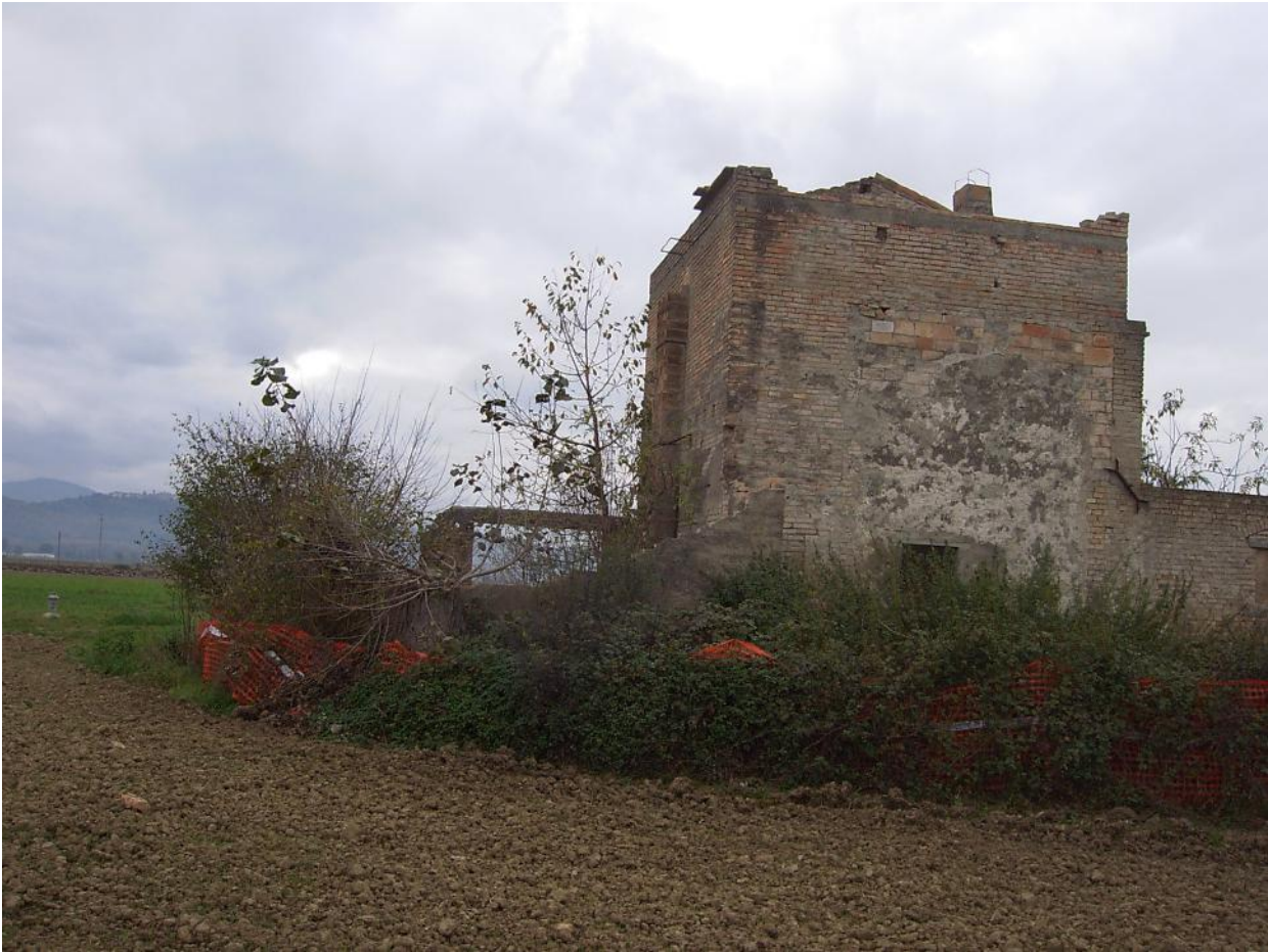
FOTO N°13: PORZIONE PROSPETTO NORD-EST
